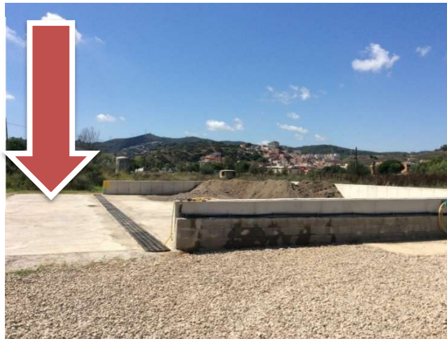
Foto 5: Espai per la càrrega dels camions banyera de 24t
