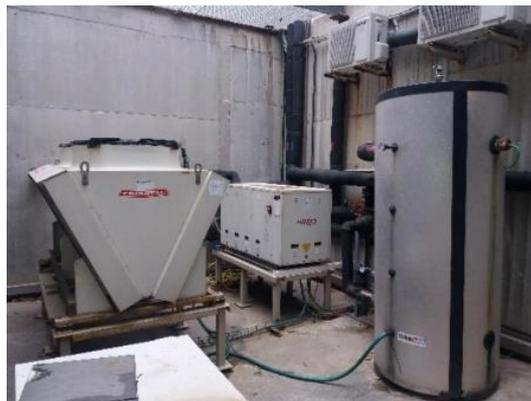
La enfriadora disipa calor a través del aerorefrigerador por aire (en forma de V). Este equipo tiene un rendimiento por debajo de sus especificaciones técnicas debido a que la ubicación dentro de la arqueta no permite un óptimo intercambio con el aire exterior. Se propone para mejorar este punto la construcción de un conducto vertical en chapa de acero inoxidable AISI-304L que permita este intercambio correctamente así como la adaptación al trámex existente en la parte superior de la arqueta.
