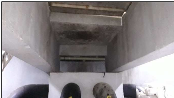
Sostre i arqueta trencament
