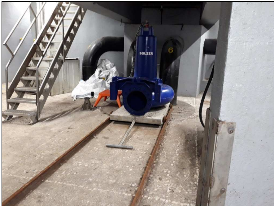
Imatge 18. Paviment, carrils guia i escala accés
