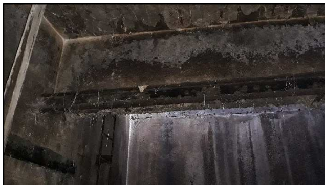
Paraments formigó i biga metàl·lica
