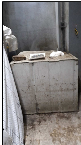
Caseta sonda nivell
