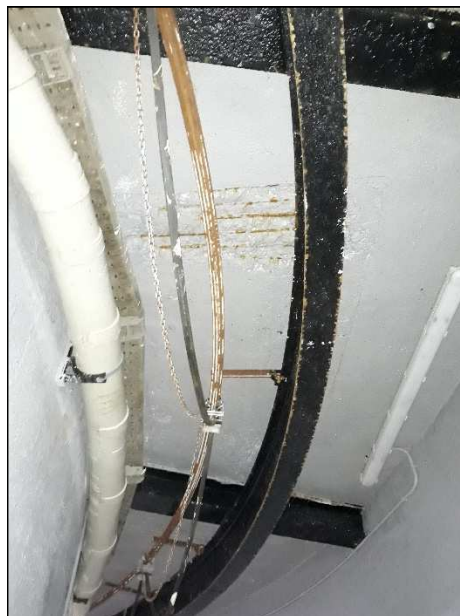
Imatge 17. Pont grua i sostre
