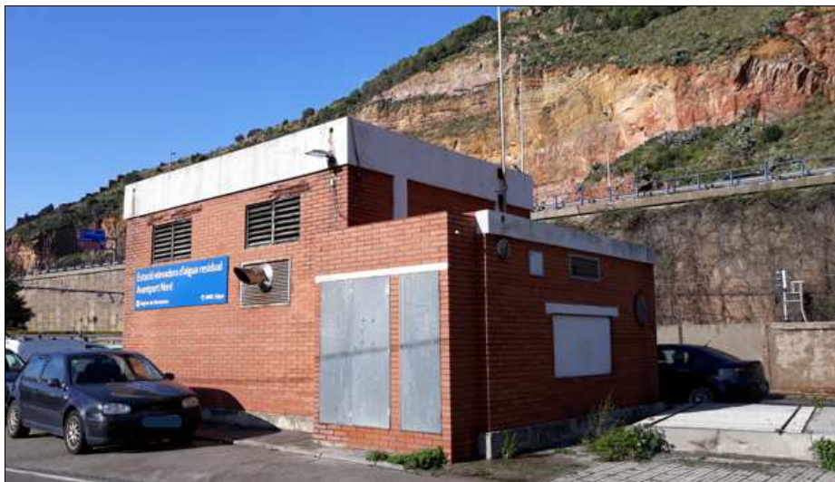
Imatge 21. Vista exterior EBAR
