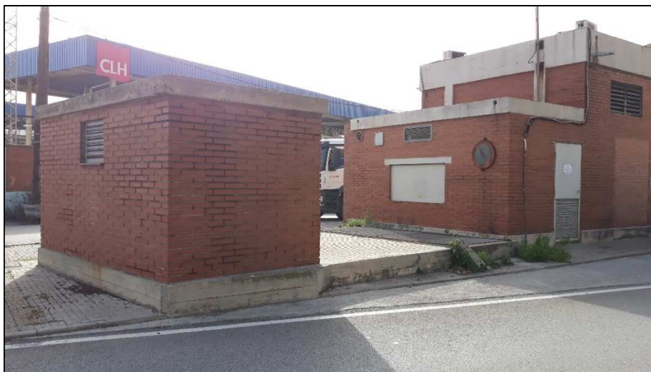
Imatge 22. Vista exterior arqueta entrada col·lector i EBAR (cantells)
