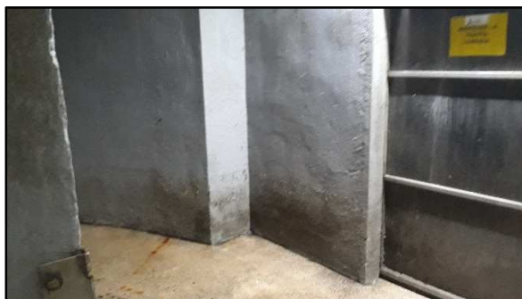
Paraments formigó i paviment
