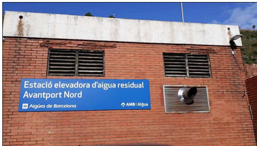
Imatge 23. Finestres tipus reixa, estat dintells i baixants enrasats
