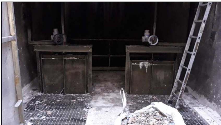
Imatge 3. Vista general
