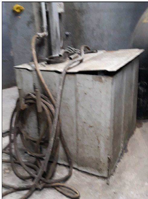
Imatge 20. Estat caseta pericó sonda nivell
