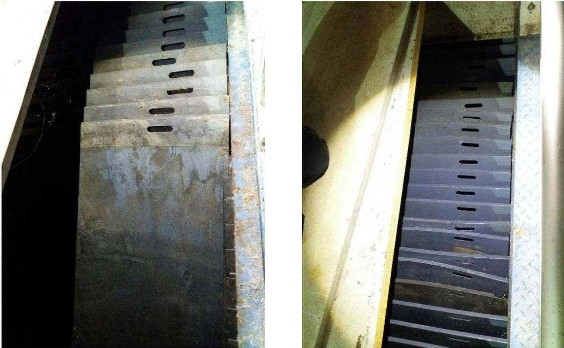
Visión parcial de las lamelas en un decantador vacío
