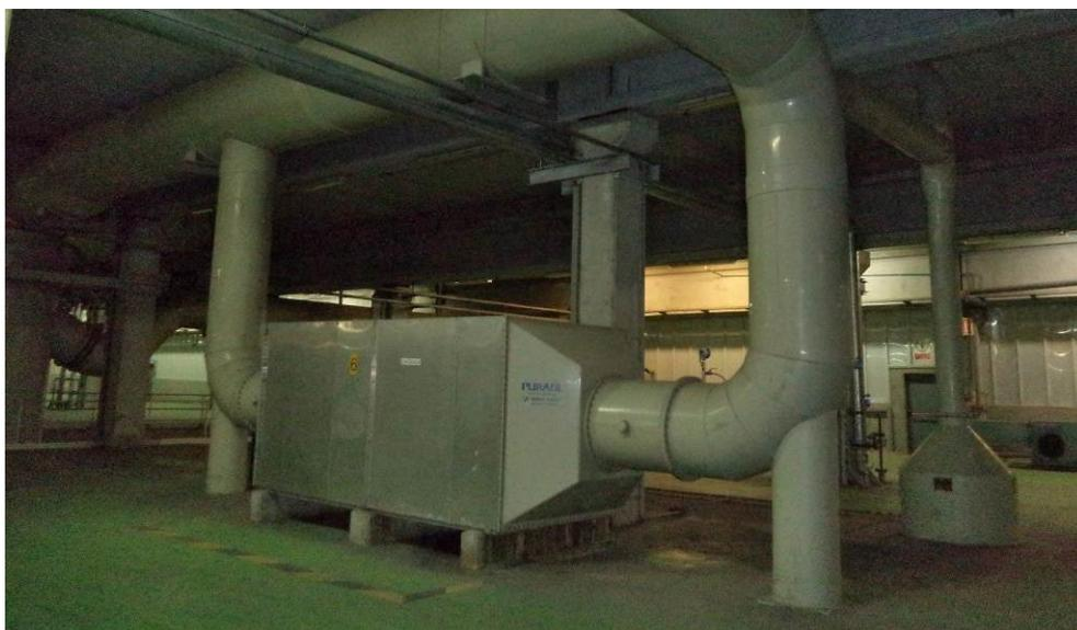
***Foto 1. Filtro de carbón activo adsorción química horizontal desodorización reactores biológicos***
