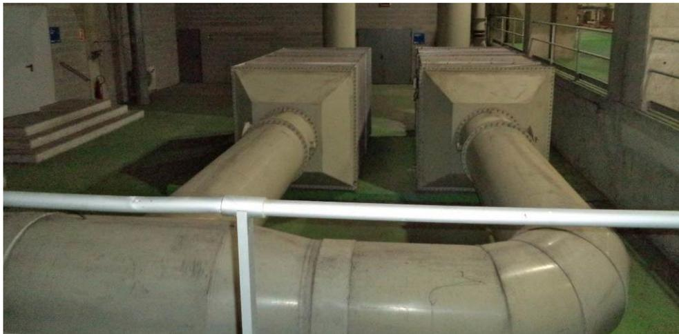
*Foto 4. Filtros de carbón activo de adsorción química horizontales desodorización decantadores secundarios*
