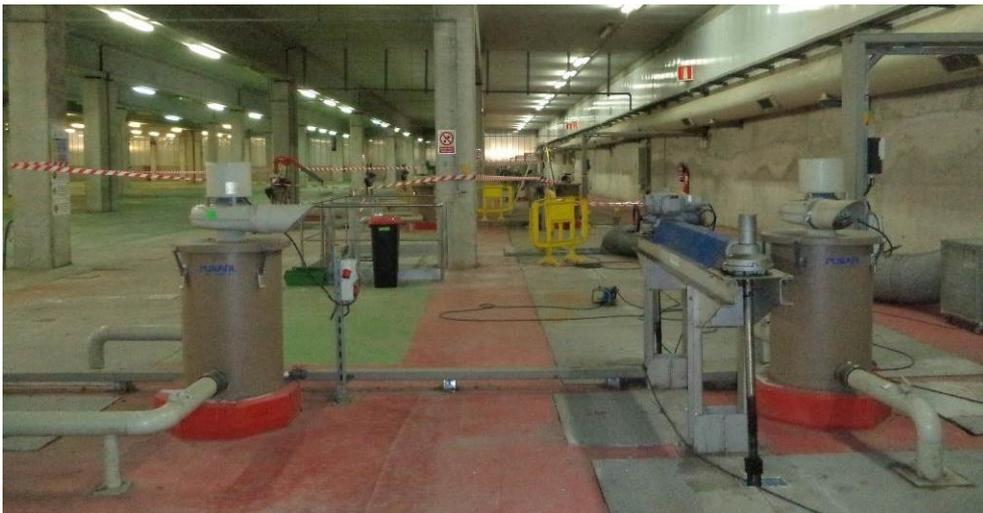
**Foto 3. Filtros de carbón activo de adsorción química tipo tambor salida decantadores secundarios**
