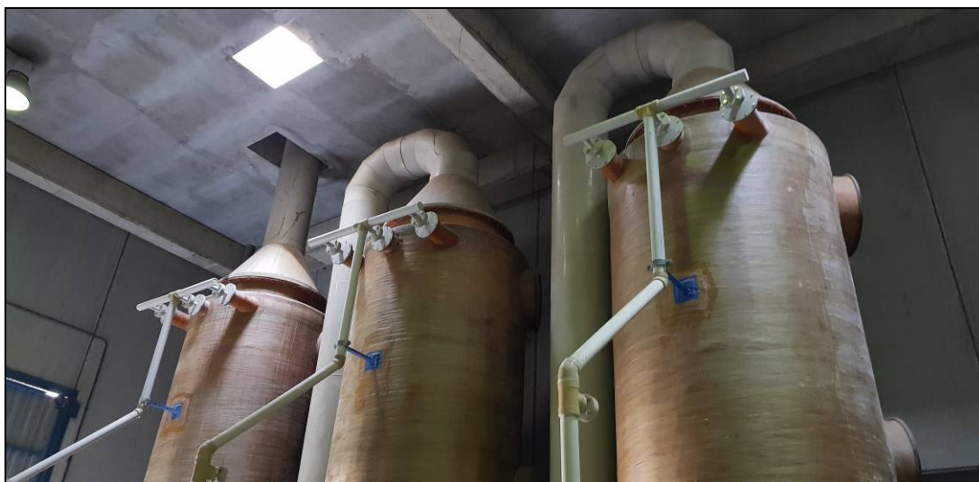
Foto 5. Tres dipòsits del tractament de desodoració, amb la xemeneia al tercer dipòsit (torre)
