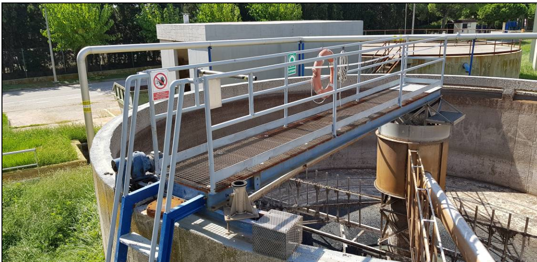
Foto 2. Espessidor de fangs primaris
