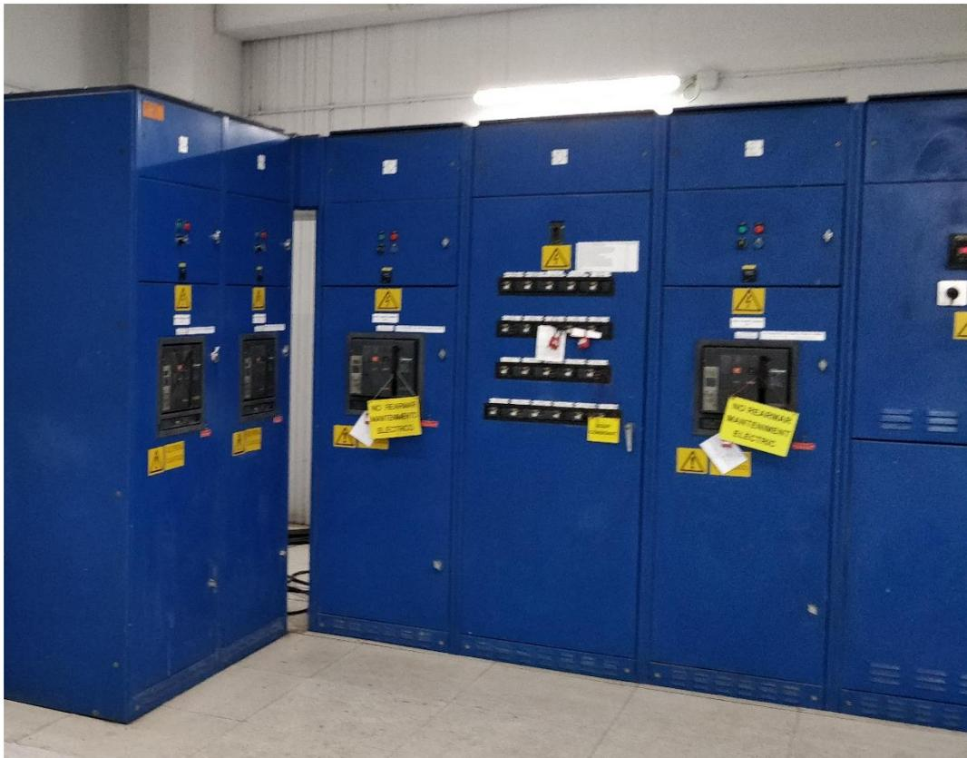
Imagen 3. Armario potencia Bombeo Emisario Módulos A-B-C-D-E.
