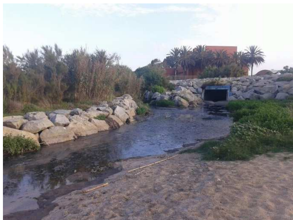
EBAR i desguàs sobreeixidor
