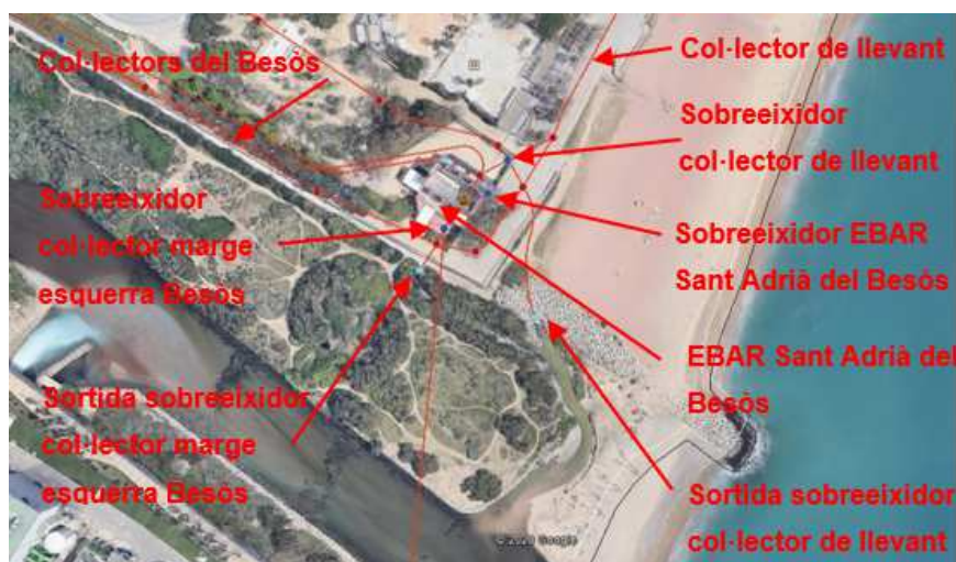
Situació EBAR Sant Adrià del Besòs i sobreexidors
