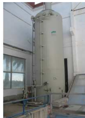
Torre de desodoració per "biotricking"
