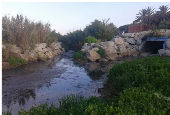
Confluència desguassos sobreexidors
