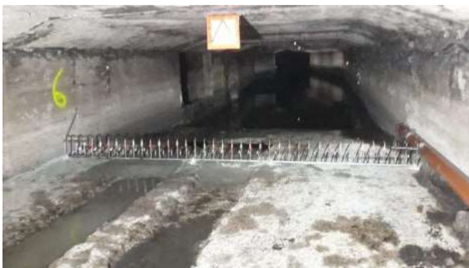
Imatge 1. Model d'instal·lació de les grapes de retenció
