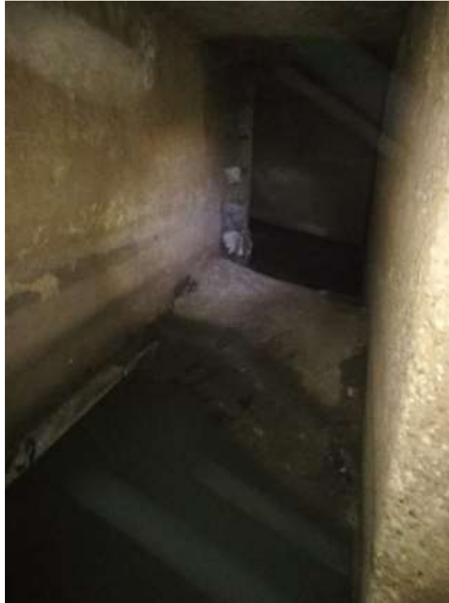
Imatge 15. Vista interior llavi sobreexidor
