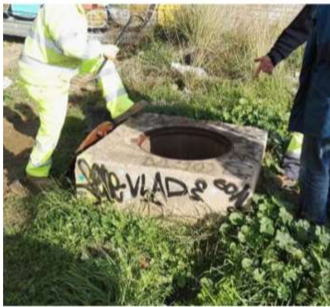
Imatge 3. Pou d'accés al sobreexidor C. Simanques (platges)
