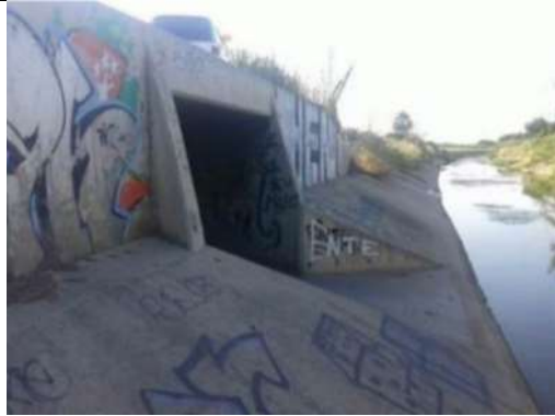
Imatge 13. Vista exterior sobreixidor N°9
