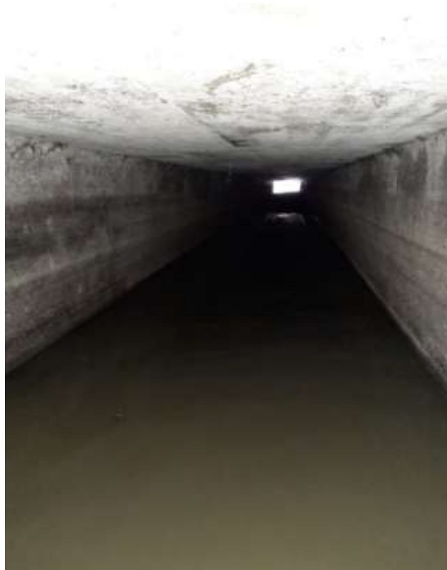
Il·lustració 12. Interior del Sobreeixidor i vista del llavi de sobreiximent C.Carme
