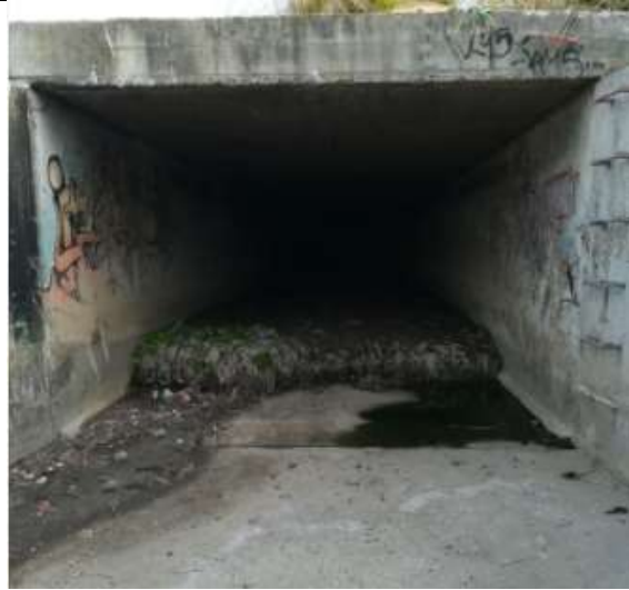
Imatge 12. Vista final calaix sobreexidor Nº8
