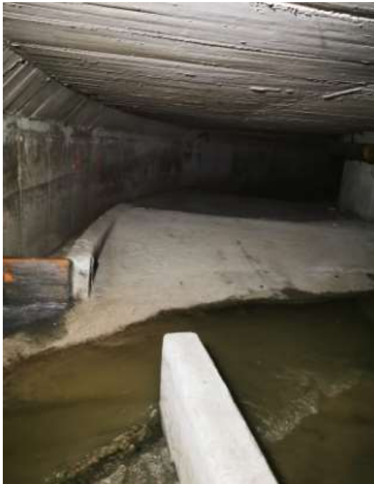
Imatge 8. Vista interior del llavi i sobreexidor N°4
