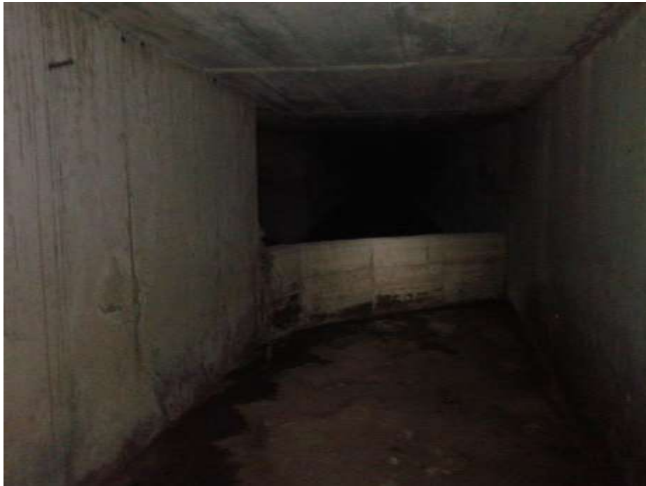
Imatge 7. Interior del Sobreeixidor i vista del llavi de sobreiximent C.Cornellà II-P
