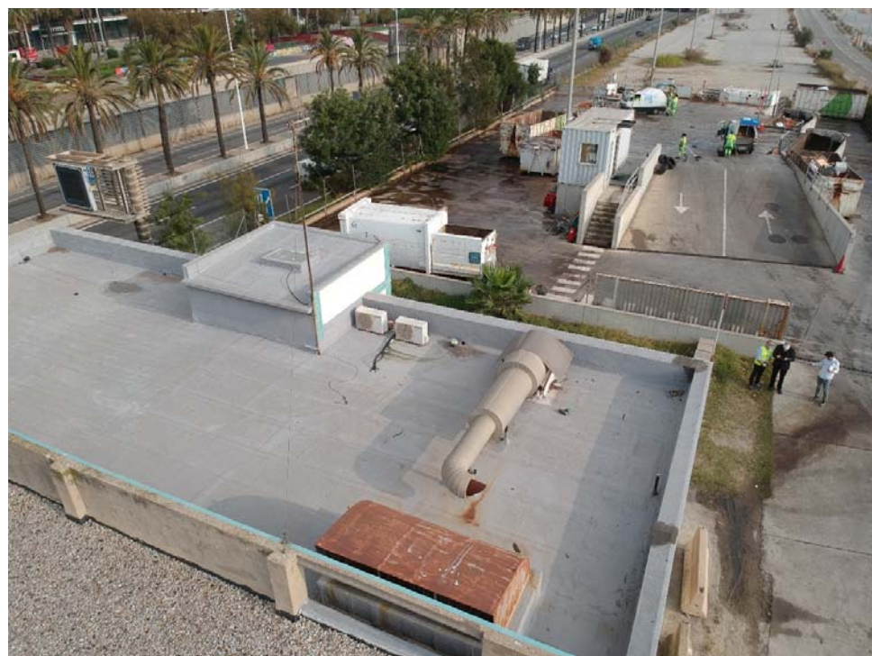
Imatge 5.- Vista de la coberta de l'edifici.
