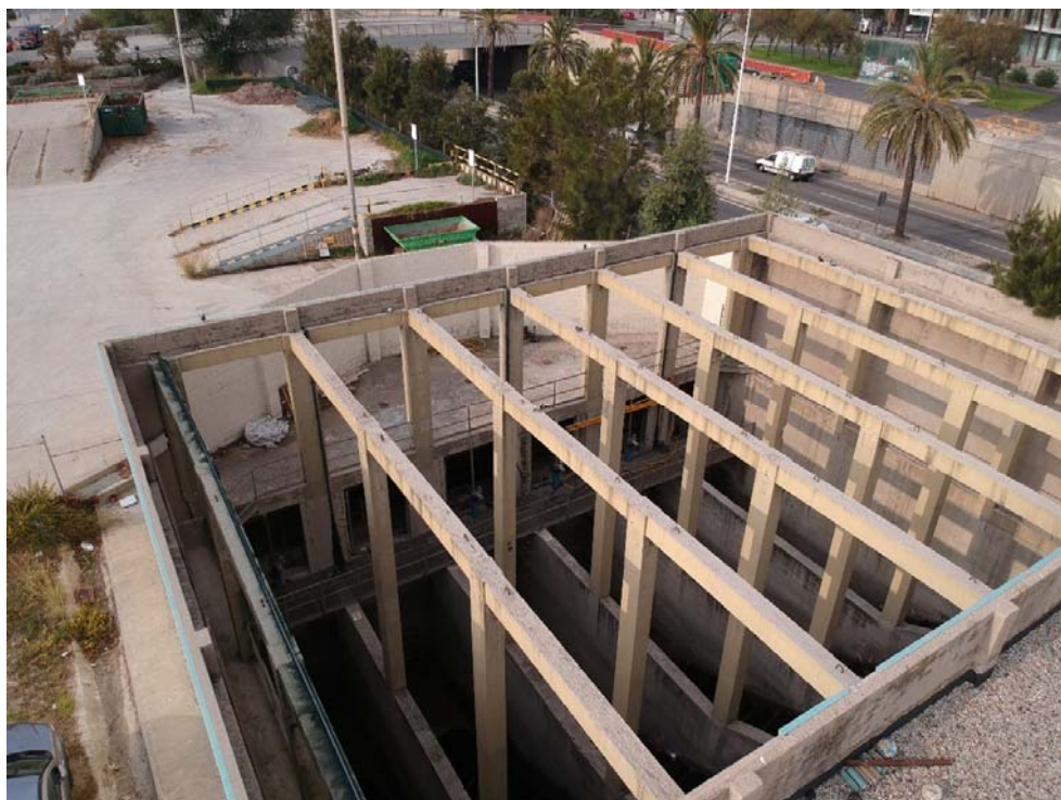
Imatge 7.- Vista cambra de cargols, on no s'instal·len plaques
