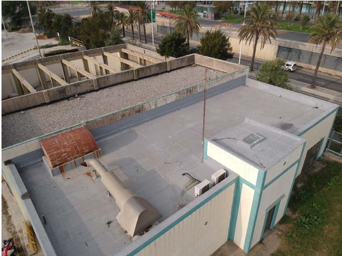
Imatge 1.- Vista de la coberta de l'edifici.
