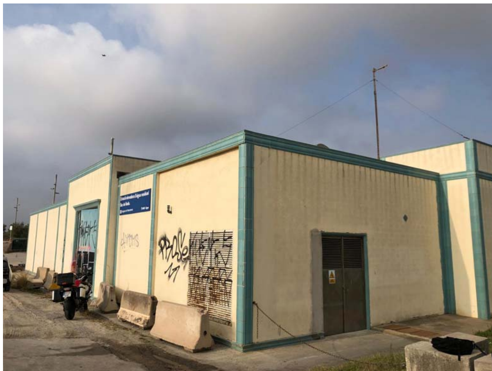
Imatge 8.- Vista exterior de l'edifici.
