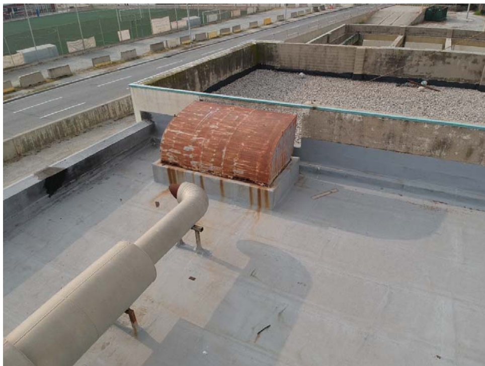
Imatge 6.- Vista de la coberta de l'edifici. Equipament a evitar
