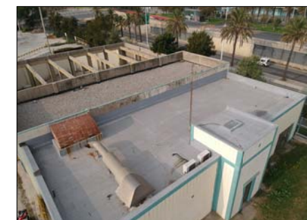
Foto 1. Vista general de la coberta
