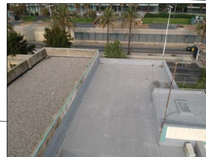
Foto 2. Detall de la coberta
