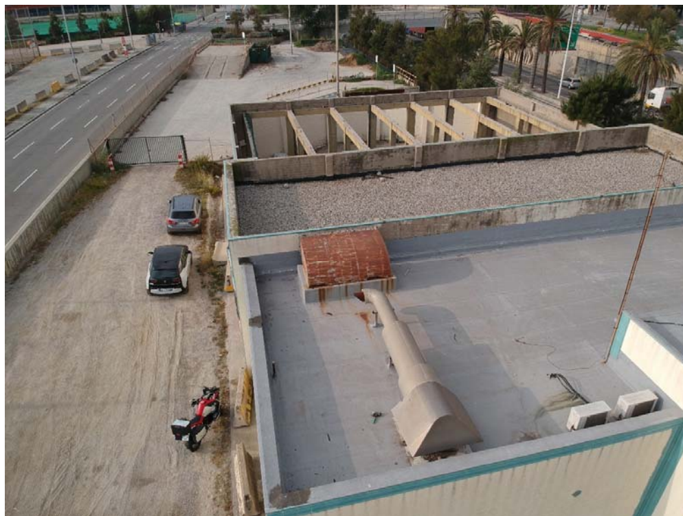
Imatge 2.- Vista de la coberta de l'edifici. Equipament a evitar
