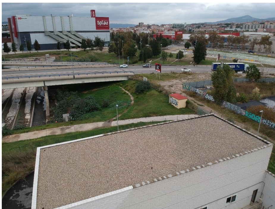
Imatge 6.- Vista coberta de l'edifici.
