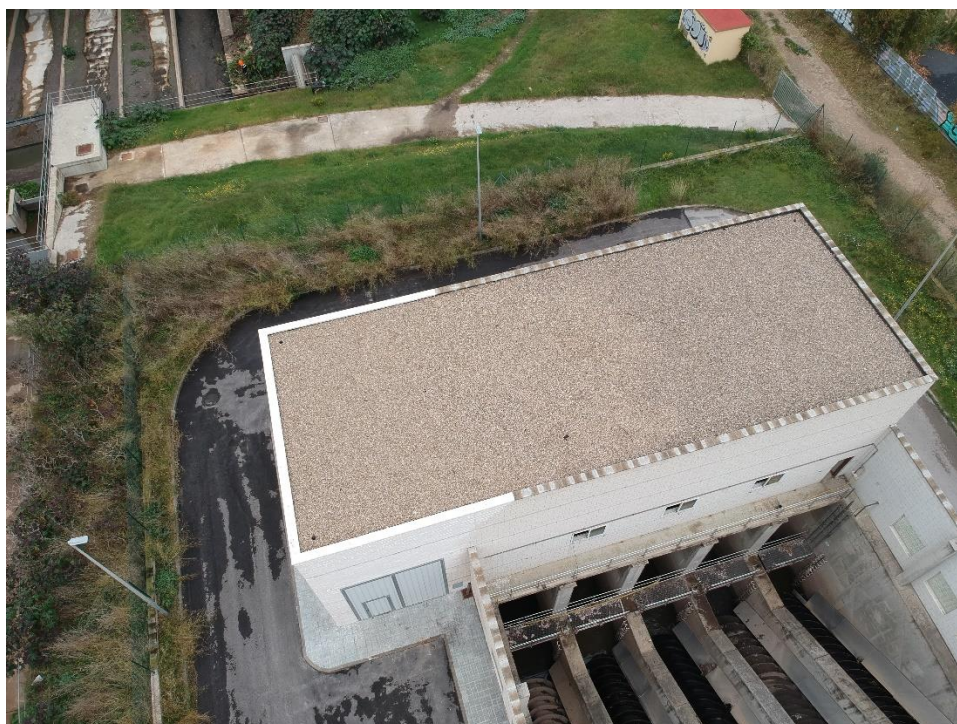
Imatge 9.- Vista coberta de l'edifici.
