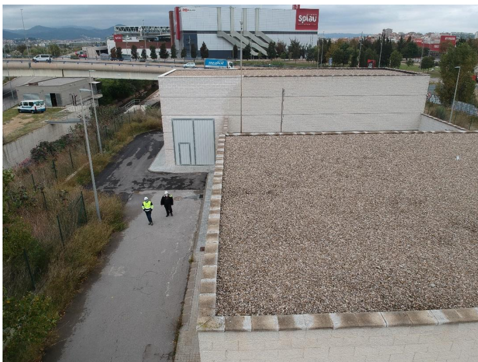
Imatge 3.- Vista coberta de l'edifici.
