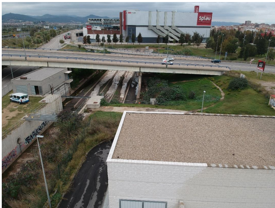
Imatge 4.- Vista coberta de l'edifici
