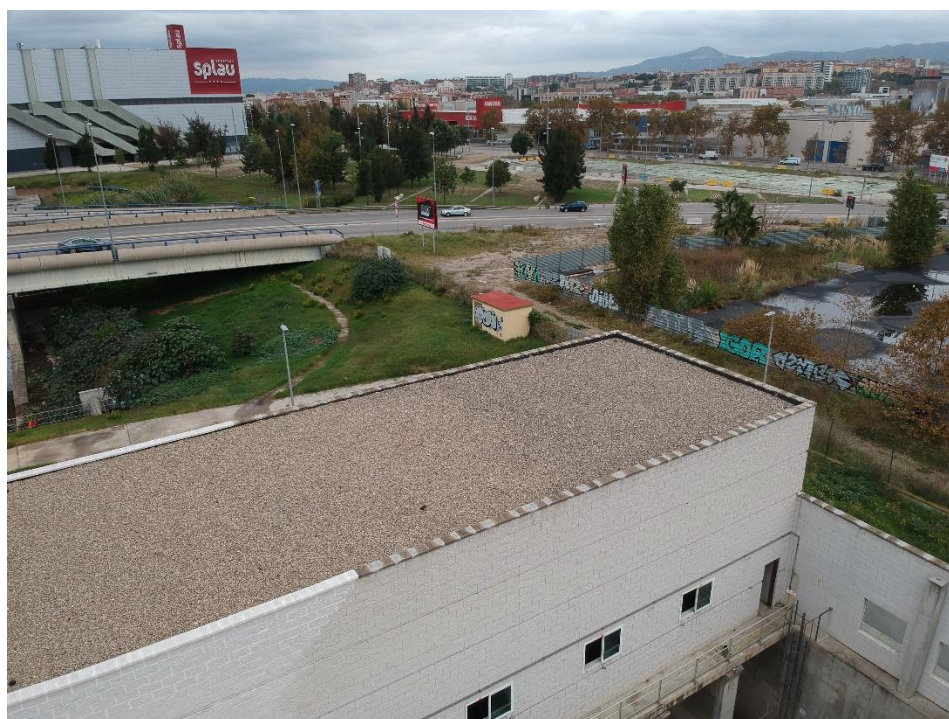
Imatge 5.- Vista coberta de l'edifici
