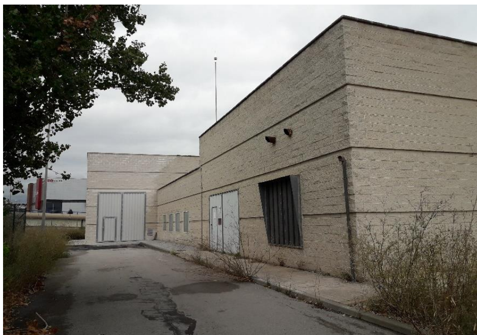
Imatge 1.- Vista exterior de l'edifici.
