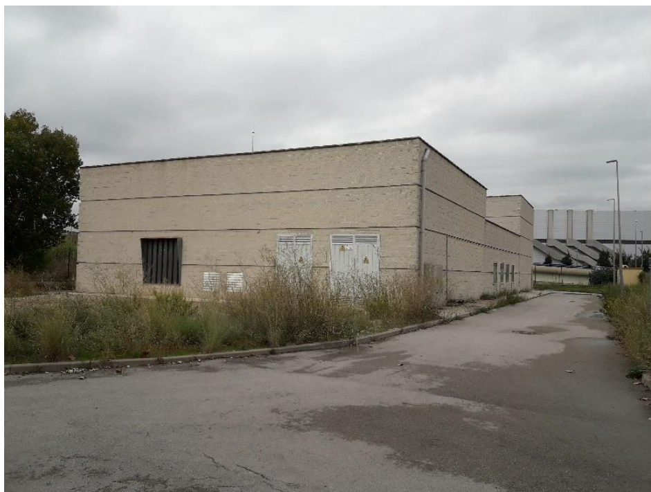
Imatge 2.- Vista exterior de l'edifici.
