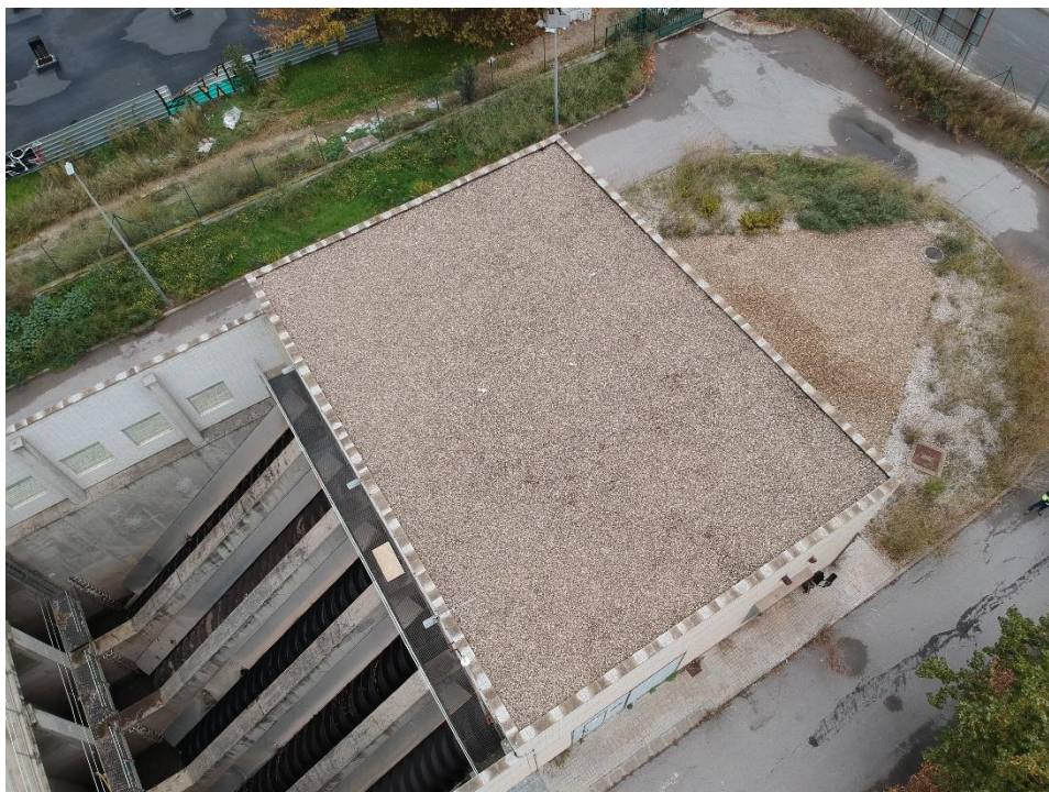
Imatge 8.- Vista coberta de l'edifici.
