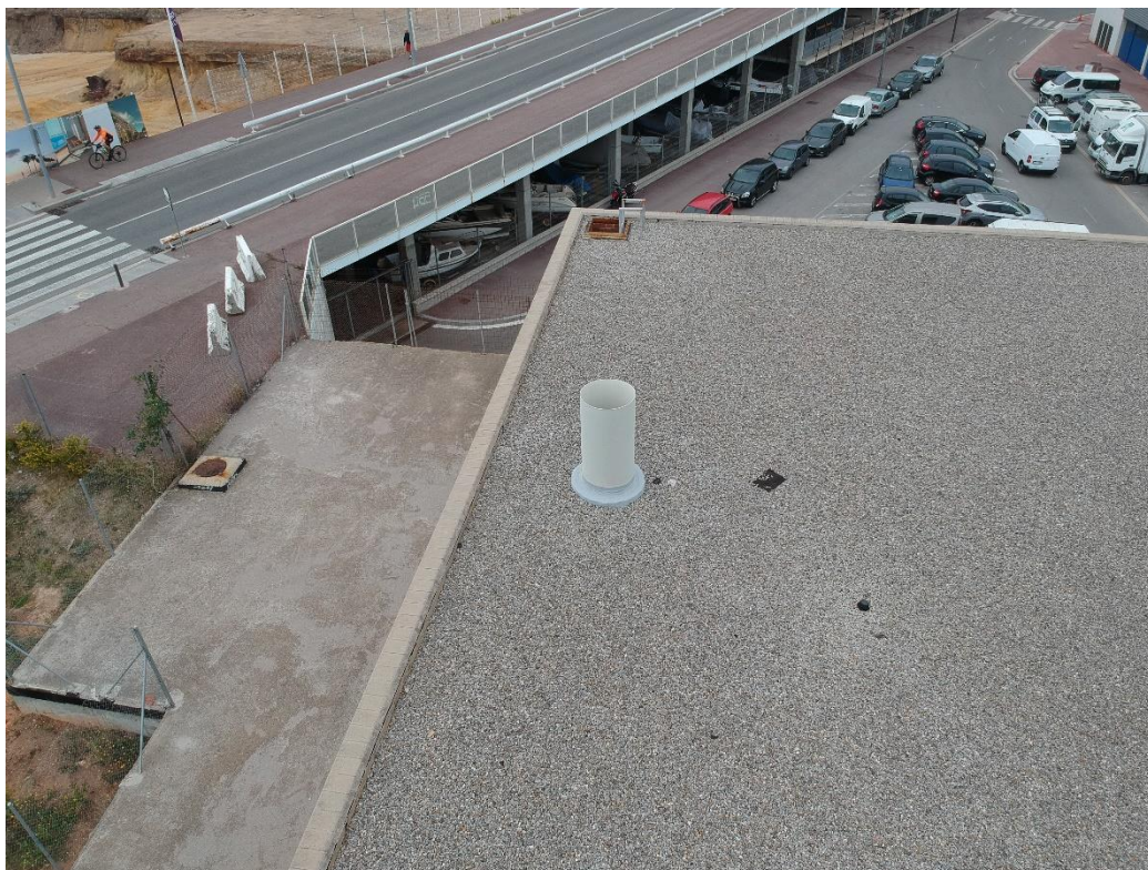
Imatge 5.- Vista de la coberta de l'edifici. Sortida de ventilació
