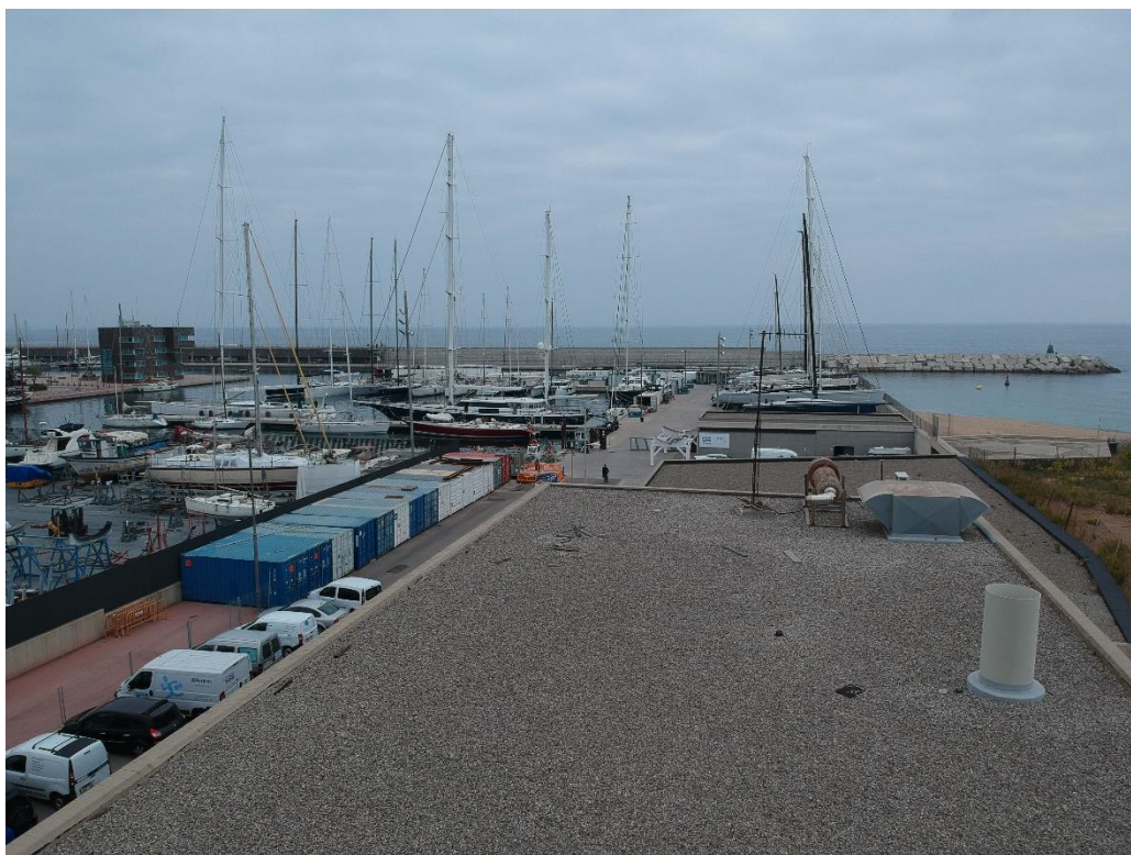
Imatge 2.- Vista de la coberta de l'edifici.
