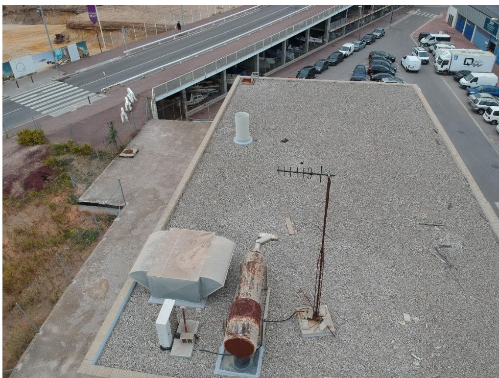
Imatge 7.- Vista de la coberta de l'edifici.
