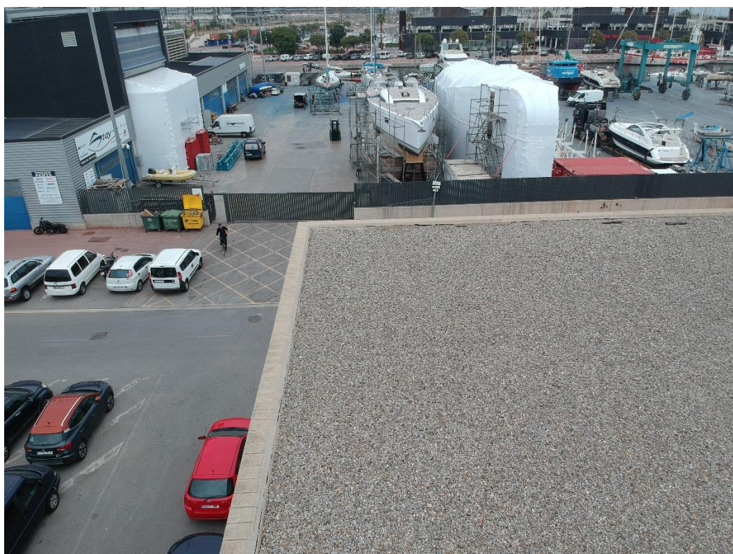
Imatge 3.- Vista de la coberta de l'edifici.
