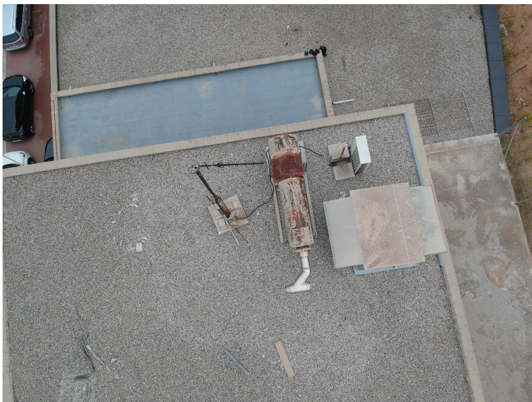
Imatge 4.- Vista de la coberta de l'edifici. Equipament de coberta a evitar
