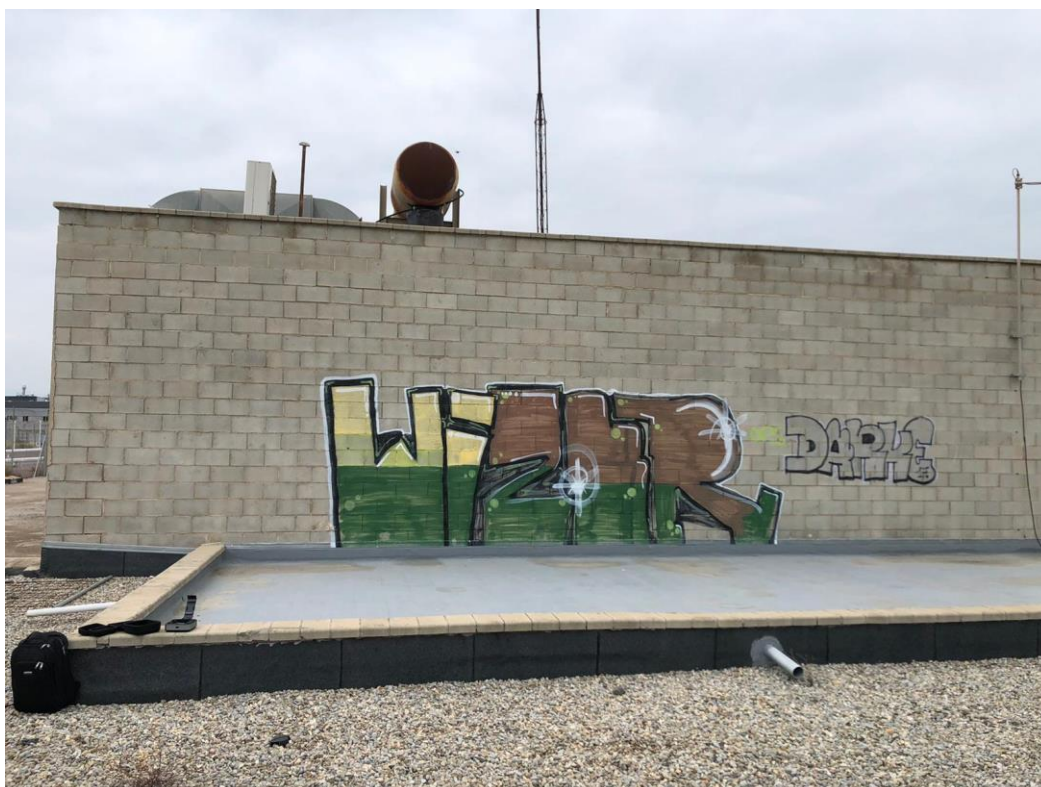
Imatge 8.- Vista exterior de l'edifici
