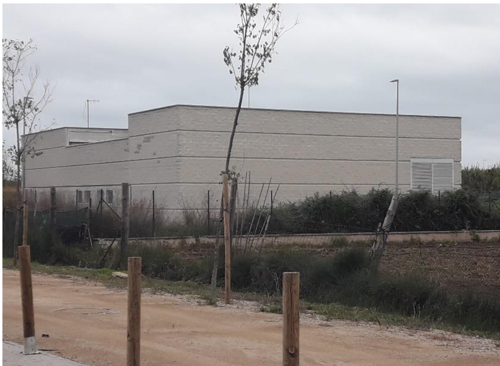
Imatge 2.- Vista exterior de l'edifici.
