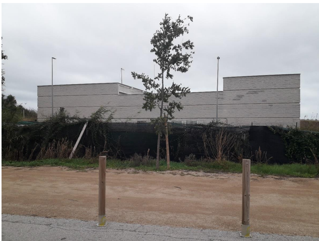
Imatge 3.- Vista exterior de l'edifici.
