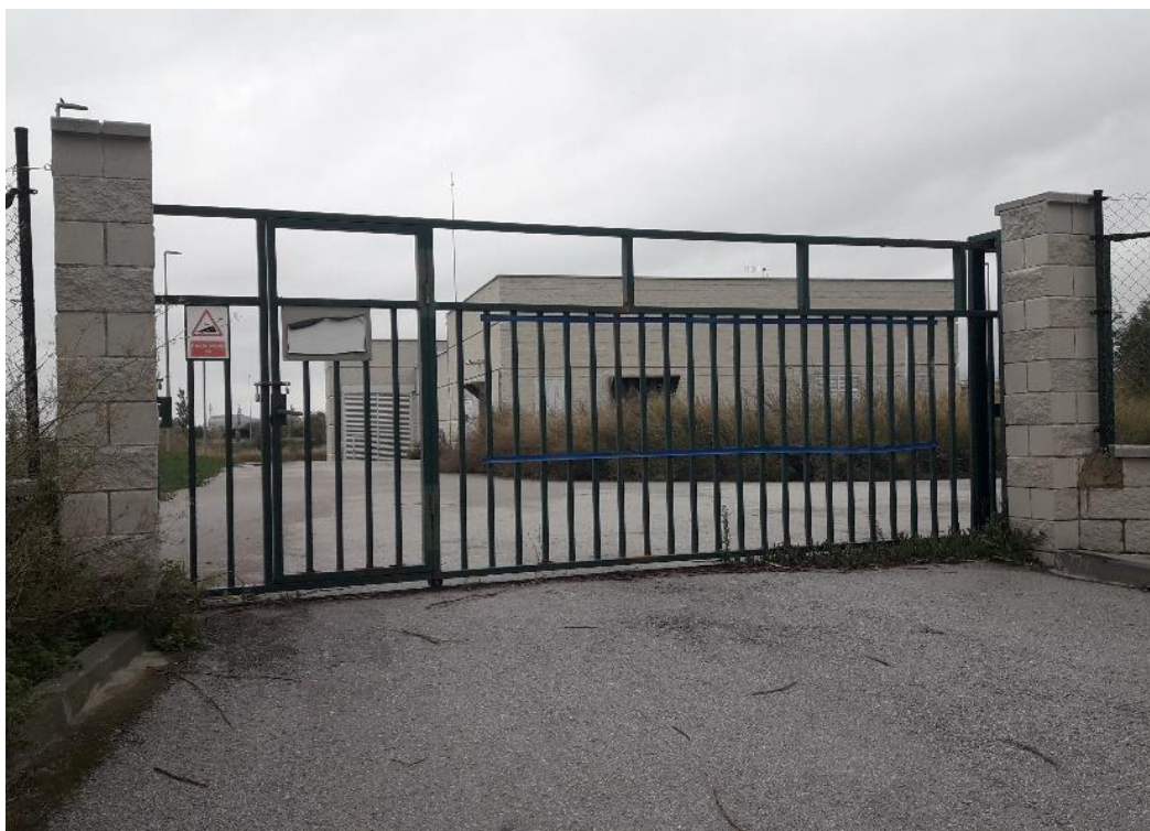
Imatge 1.- Vista accés a l'edifici.
