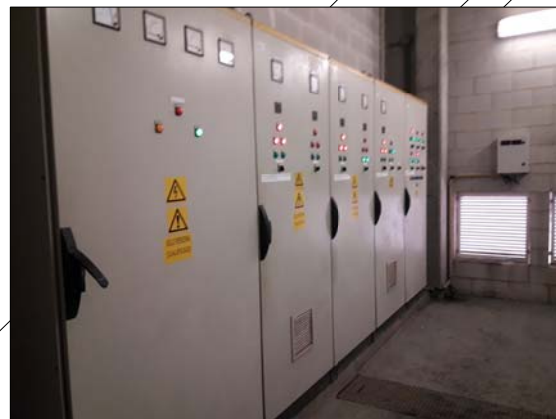
Foto 2. Sala de quadres.
