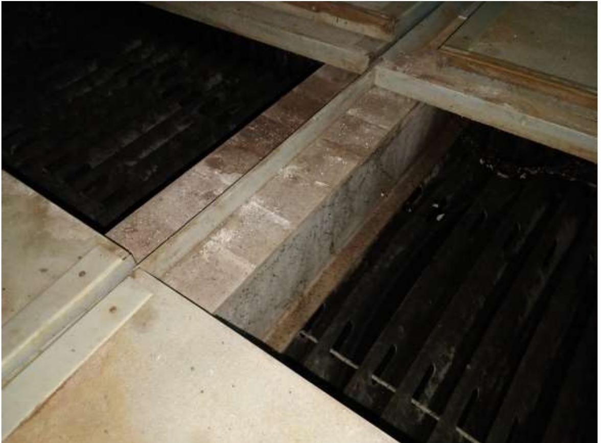
*Imagen 9. Perfil en viga doble para evitar deslizamiento tapas.*
