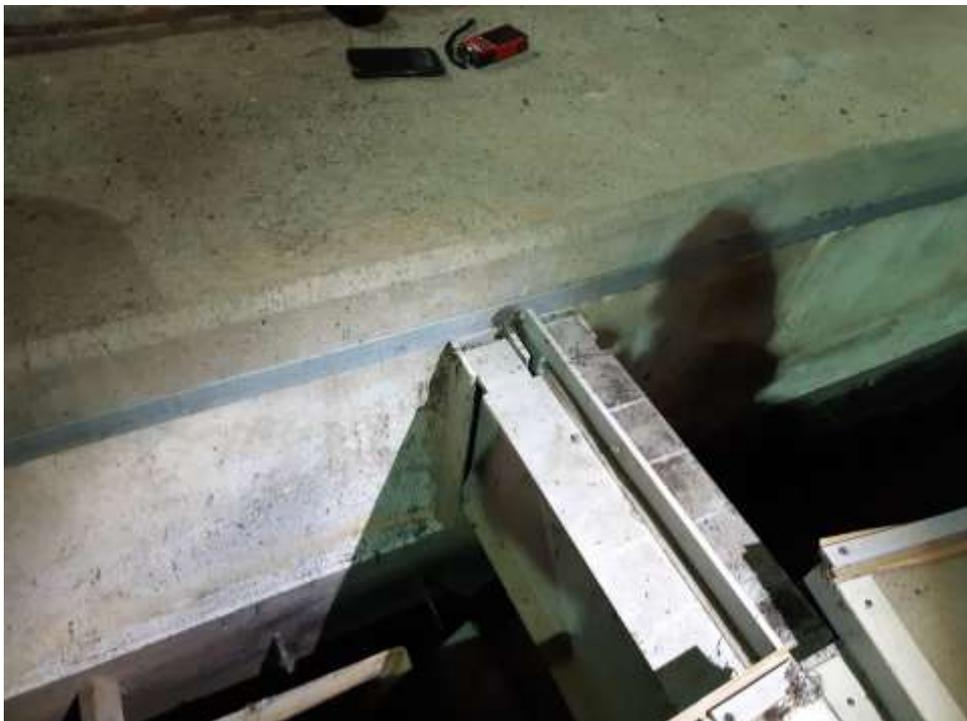
*Imagen 6. Soporte viga en lado pared. Caso viga doble.*
