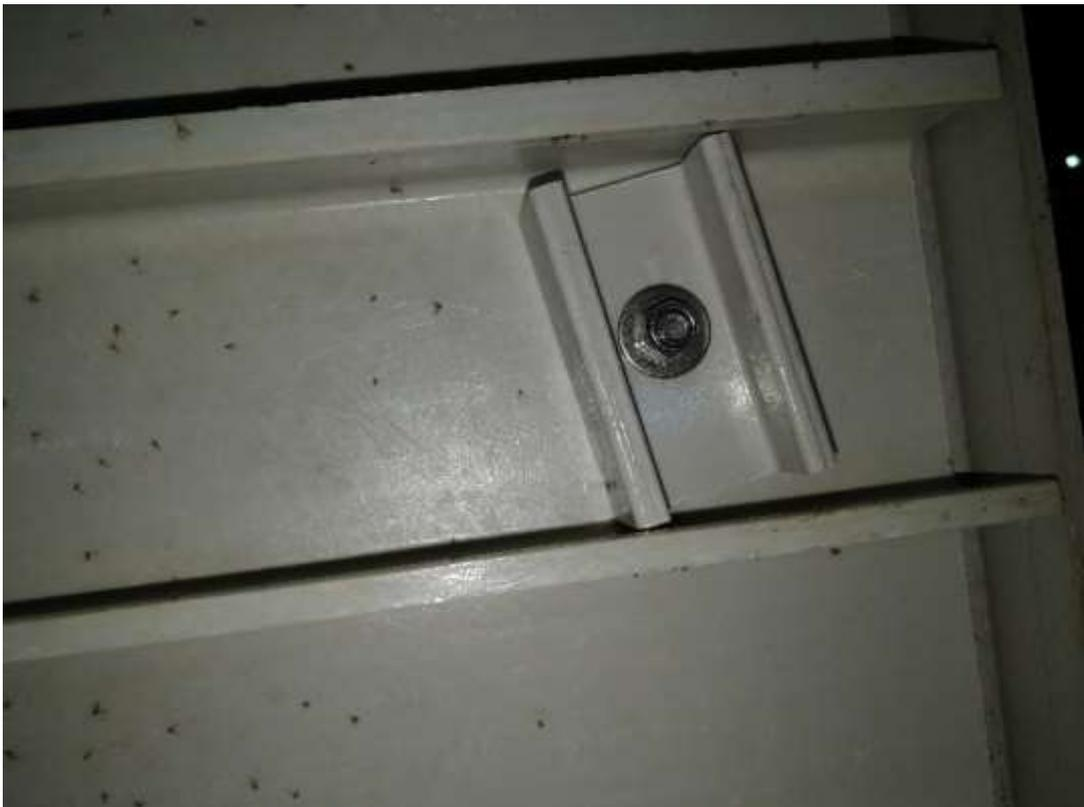
*Imagen 12. Ejemplo refuerzo inferior del tirador.*
