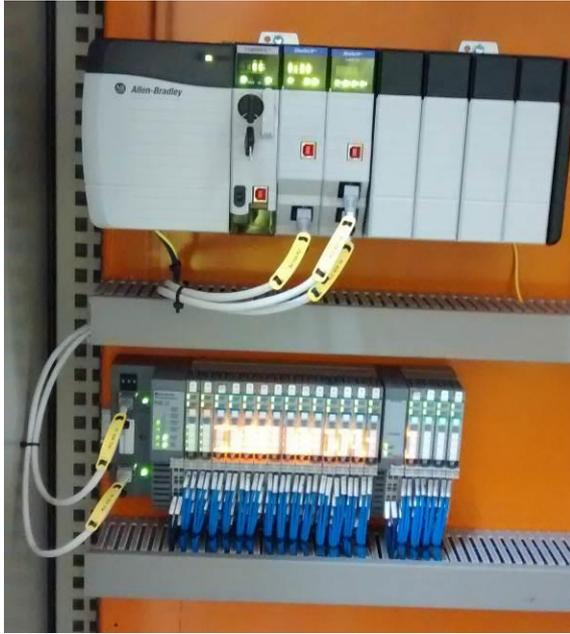
PLC CGDBT y Point I/O a conectar en anillo ETH
